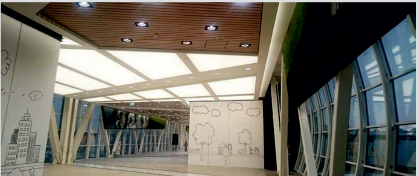
CENTRO COMERCIAL - RUSIA INSTALACIÓN : CLIPSO UNION
