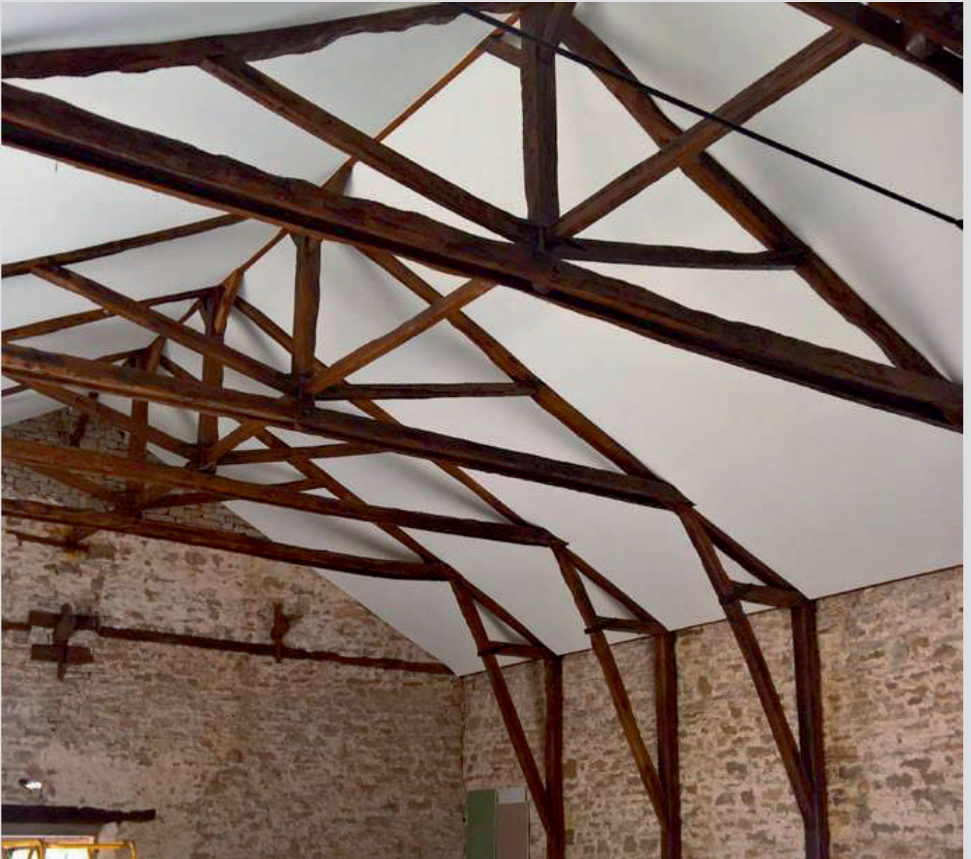
RESIDENCIAL - FRANCE TECHO BLANCO ENTRE BIGAS - INSTALACIÓN : SIGNAL SARL
