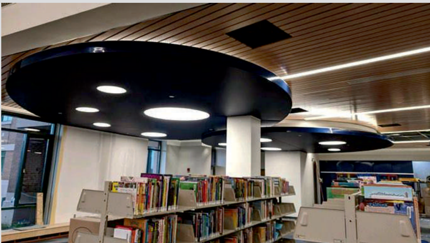
Dakota County Galaxie Library - Apple Valley, MN - USA CAJONES ACÚSTICOS CUSTOM XXL - ARQUITECTO : BTR Benz Thompson Rietow. INSTALACIÓN : INNOVATIVE Acoustics, Inc
