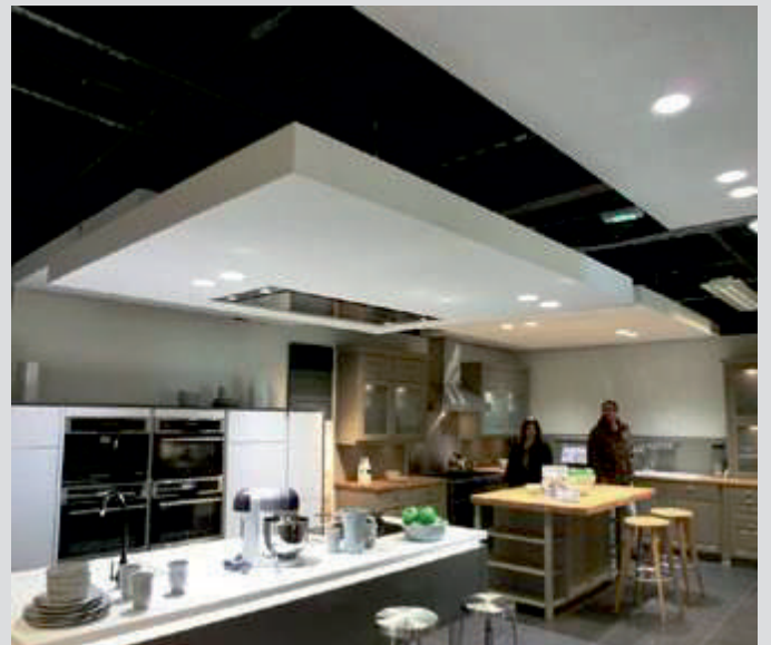
ESPACIO DE VENTA - FRANCIA CAJONES ACÚSTICOS XXL - INSTALACIÓN : KALLISTE
