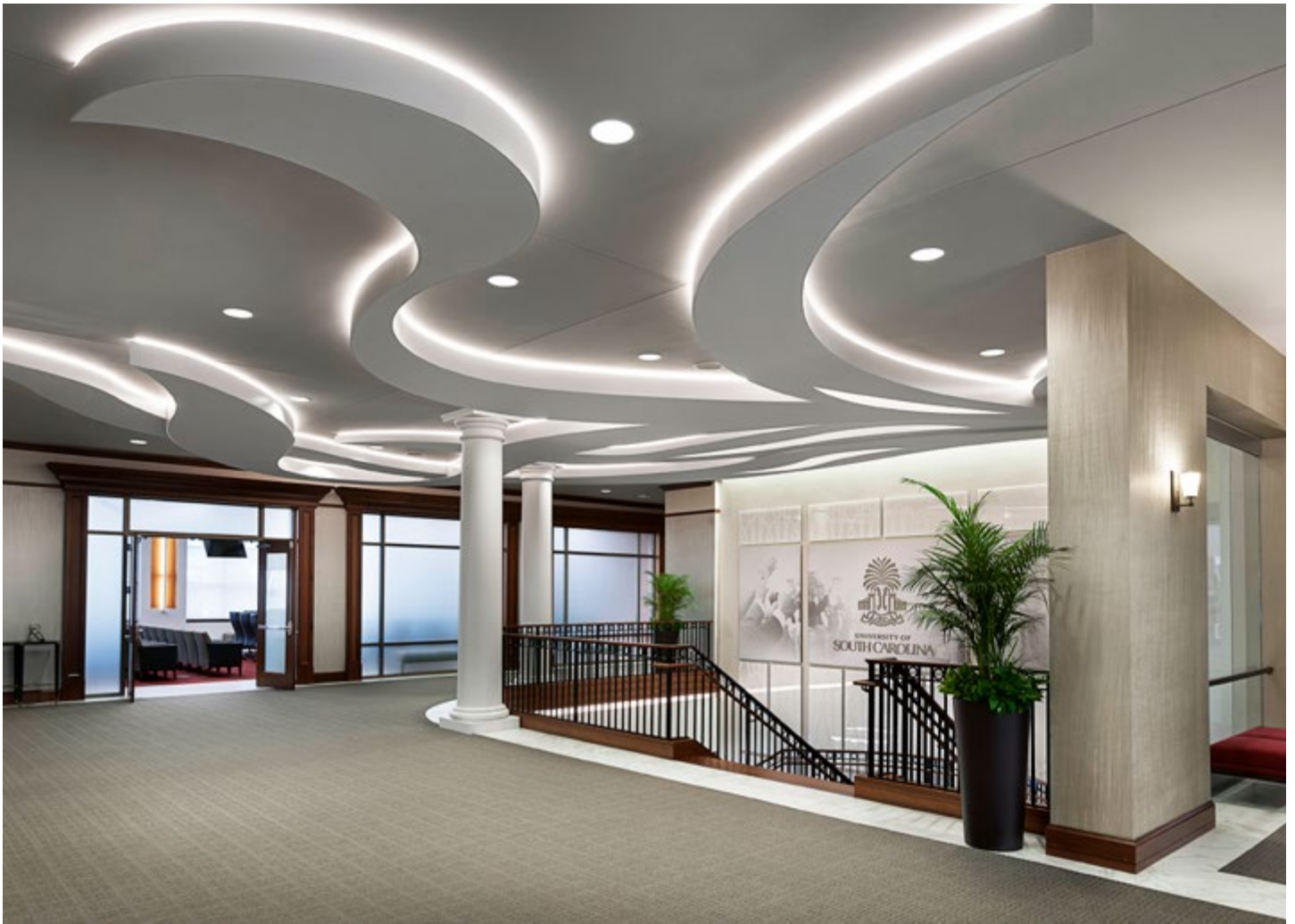
Université de Caroline du Sud - ETATS-UNIS - Plafond acoustique Architecte : L3SP - Installation : Warco Constructions Inc.
